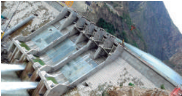
Proyecto Hidroeléctrico de Cerro del Águila - Perú
