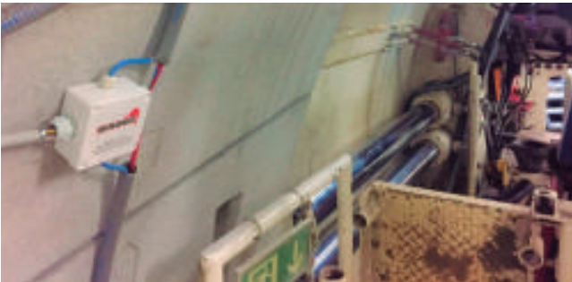
Túneles hidráulicos Riachuelo - Argentina
